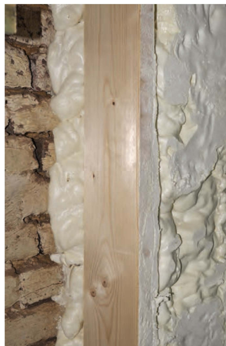
Намаляване на топлинни мостове
